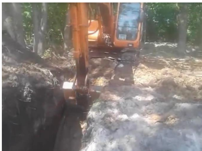
Рис. 4. Устройство нагорной канавы
