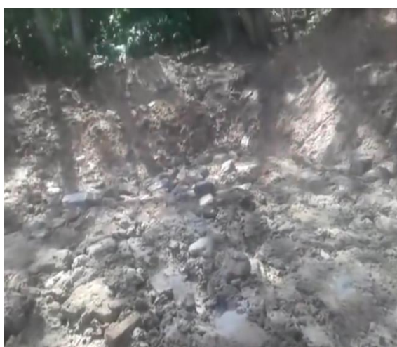
Рис. 11. Цементация грунтов с использованием б/у строительных материалов
