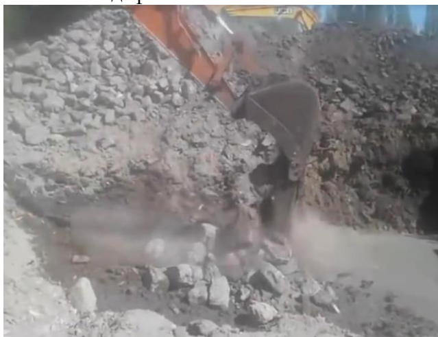
Рис. 9. Отсыпка сухого шлакоблока
