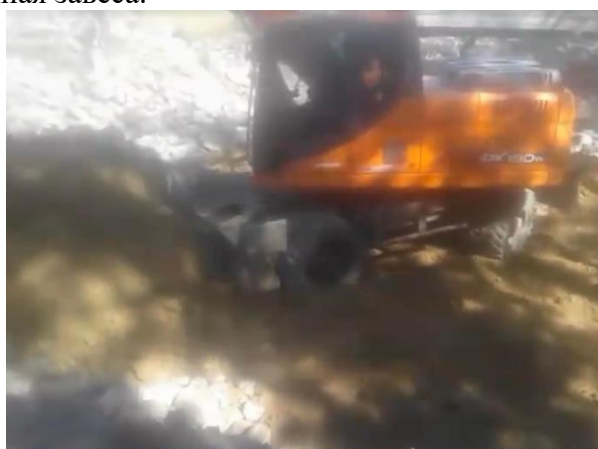
Рис. 8. Укрепление грунта на подтапливаемой территории при помощи строительного мусора
