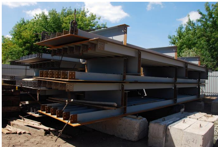
Рис.1. Ортотропная плита
