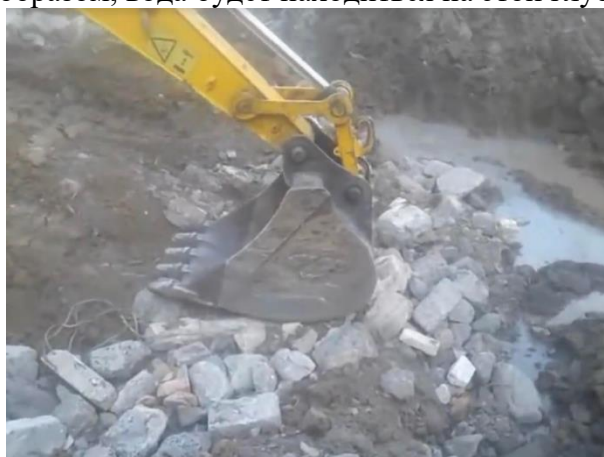
Рис. 7. Втрамбовка сухого шлакоблока в водонасыщенный грунт
